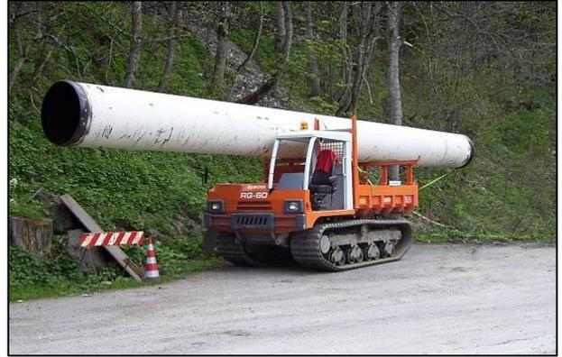
L'apertura dello scavo sarà al massimo per una lunghezza pari a due/tre virole, ovvero 18/24 m e, le stesse saranno approvionate in cantiere all'occorrenza con alloggiamento sui dumper (vedi foto).
