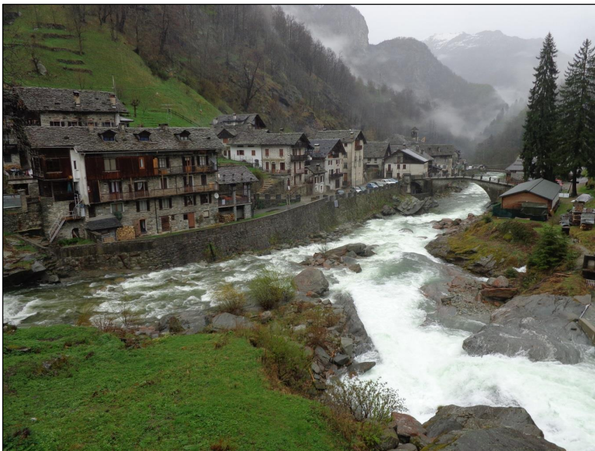
Rassa concentrico - confluenza torrenti Sorba-Gronda - vista verso valle.
