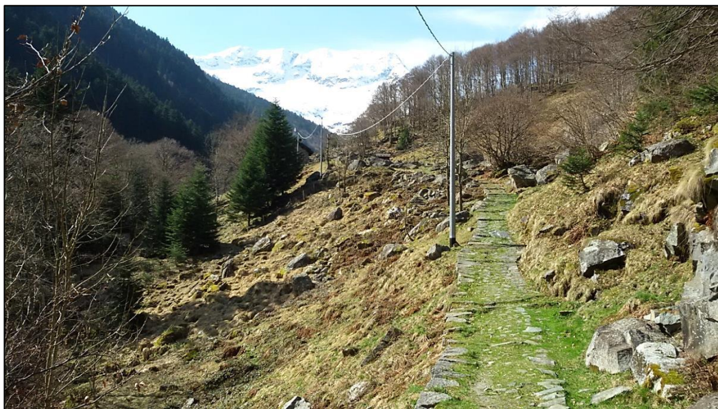
F1 - Strada comunale della Val Sorba (viabilità principale)- tratto mulattiera a carretto - vista verso monte - sito opera di presa
