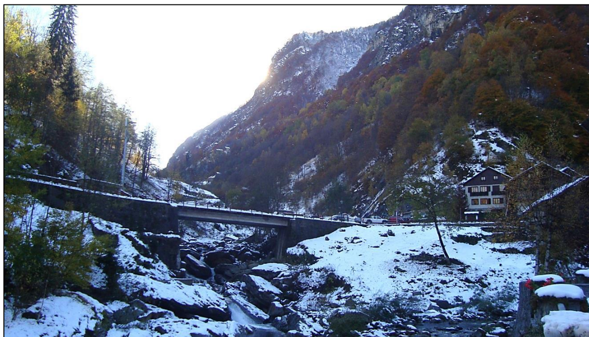
F28 - CENTRALE DI PRODUZIONE VISTA DA VALLE DAL PONTE AD ARCO DEL CENTRO ABITATO
