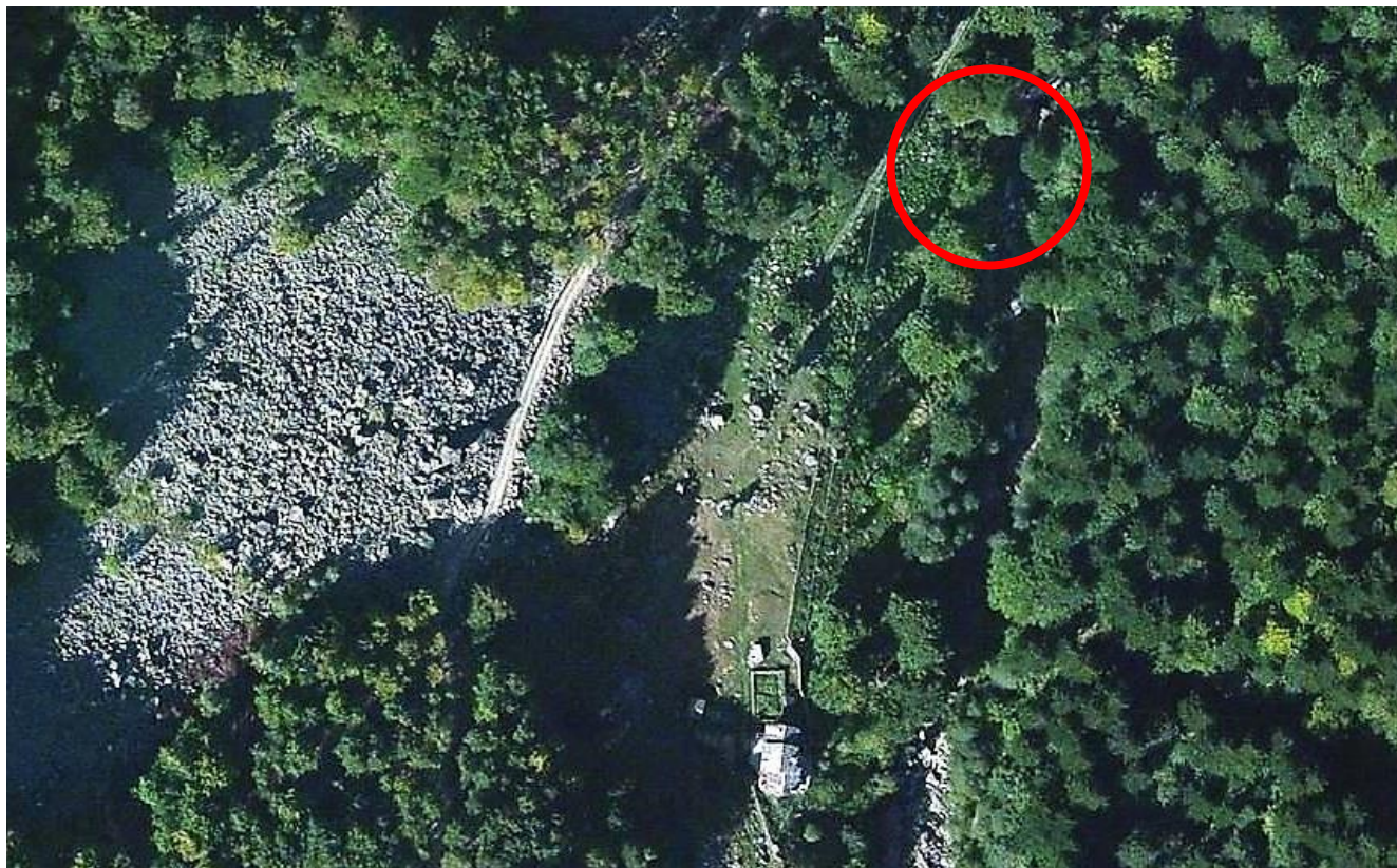
Vista aerea - OPERA DI PRESA.
