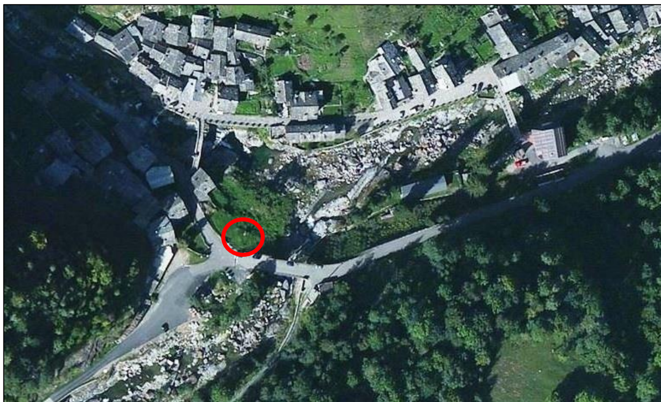
Vista aerea - CENTRALE DI PRODUZIONE.
