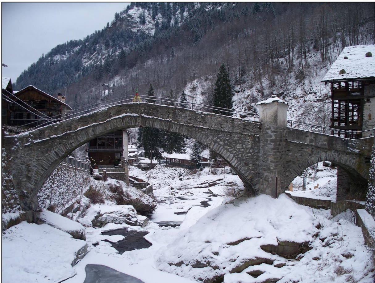
Rassa concentrico - ponte sul Gronda - vista da monte.
