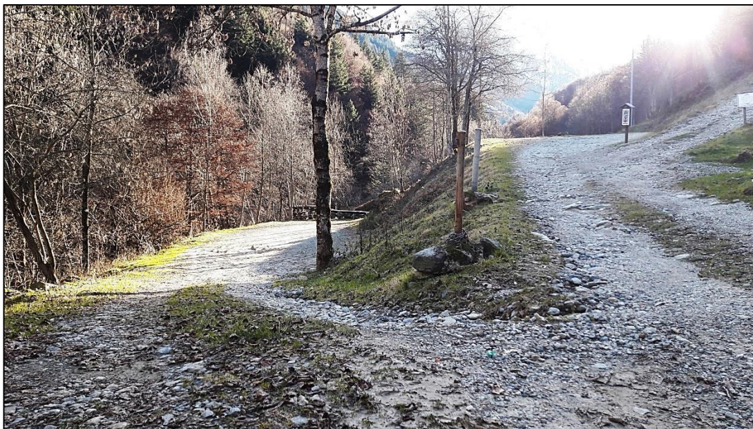
F9 - Strada comunale della Val Sorba (viabilità principale)- tratto parcheggio superiore - vista verso monte
